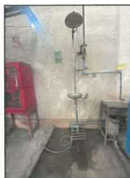
รูปที่ 3-29 อ่างล้างตาและฝักบัวฉุกเฉิน
