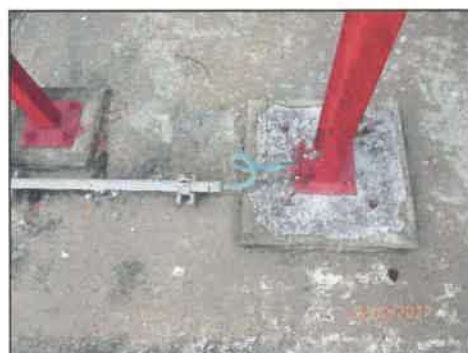
รูปที่ 3-49 ระบบสายดินบริเวณกักเก็บก๊าซไฮโดรเจน
