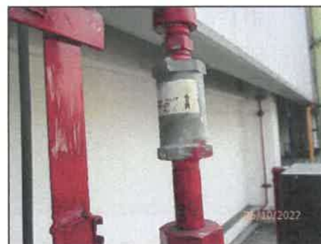
รูปที่ 3-50 อุปกรณ์ป้องกันก๊าซไหลกลับในท่อ (Check Valve)
