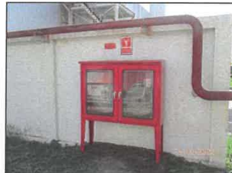
รูปที่ 3-52 ระบบป้องกันและระงับอัคคีภัยภายนอกอาคาร
